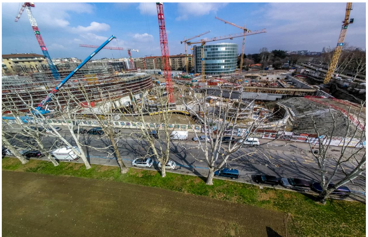
Immagine cantiere Bocconi Urban Campus a Milano (committente Università Bocconi)
