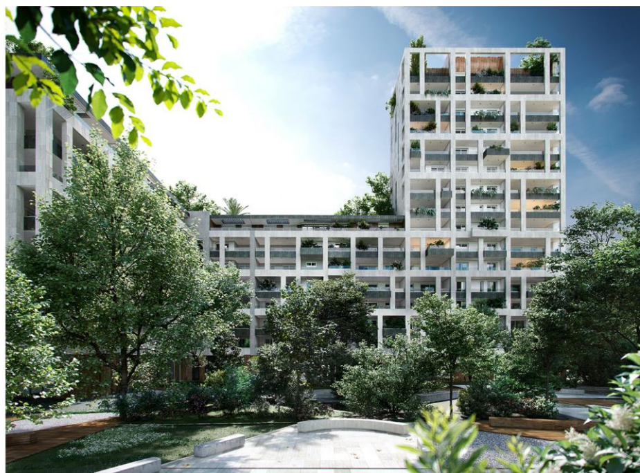
Milano City Village, Milano, in corso di realizzazione (committente Milano City Village S.r.l.)
